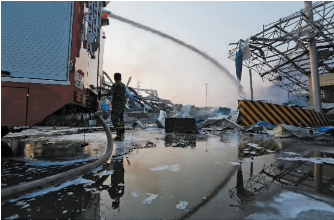
13日,天津消防某支队的消防人员在爆炸现场的西部区域某个着火点附近灭火。 新华社发
