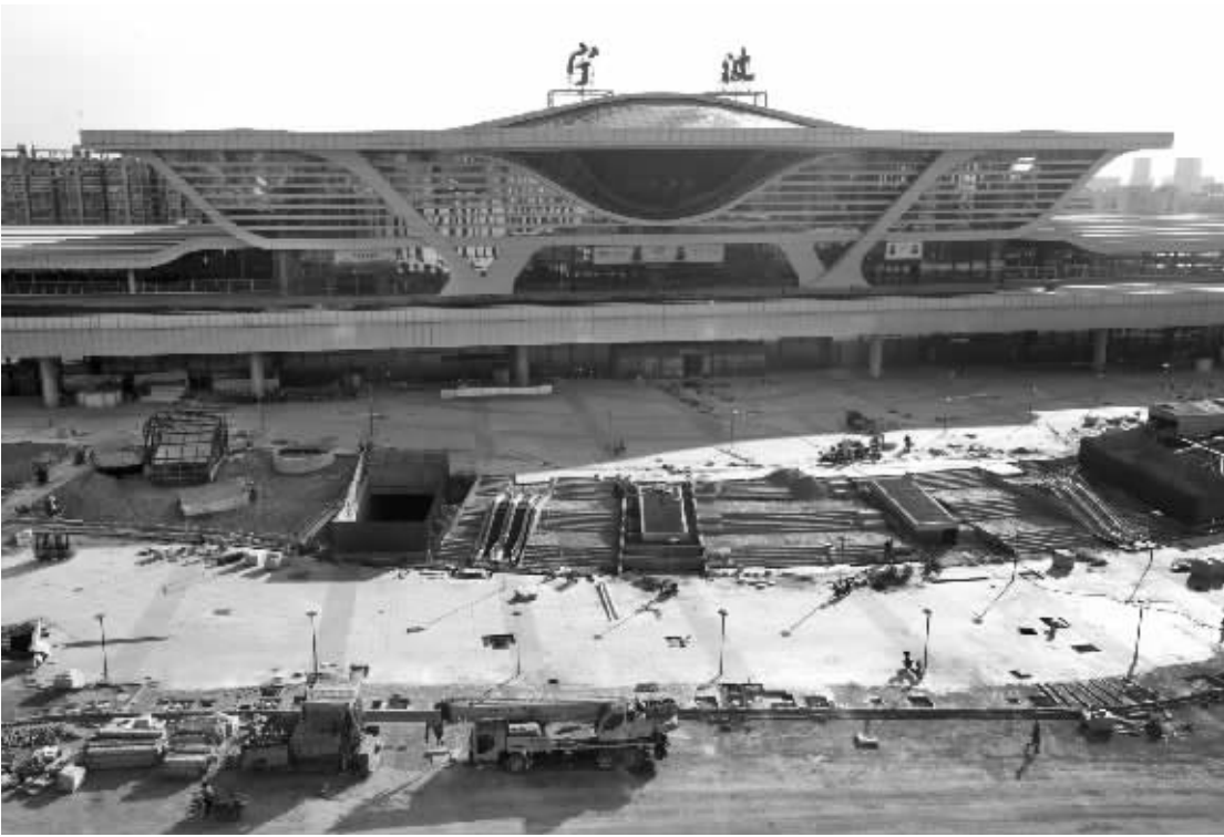
昨天下午,拆除施工围栏的铁路宁波站北广场进入最后一项路面铺装扫尾工作。 记者 龚国荣 摄
