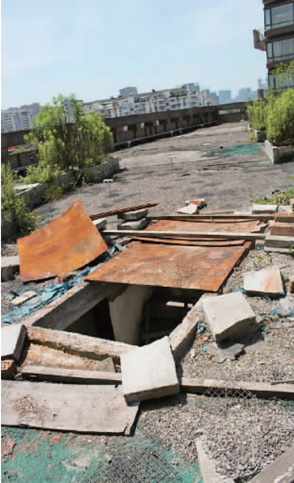
挖开屋顶建通道
