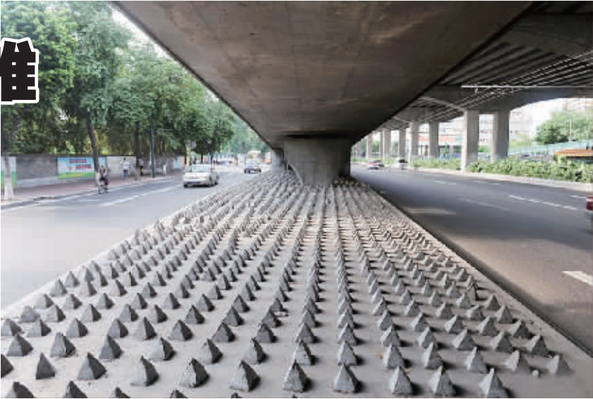
在白云机场高速黄石南入口的高架桥下,近200平方米的平地上长满了森然的“牙齿”。
