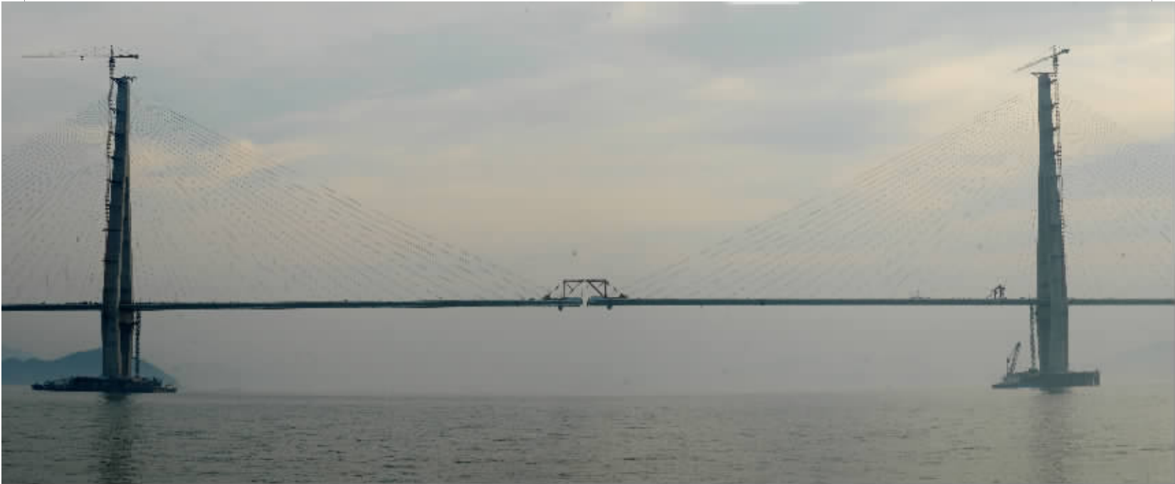
合龙前一天的象山港大桥。 记者 龚国荣 摄
