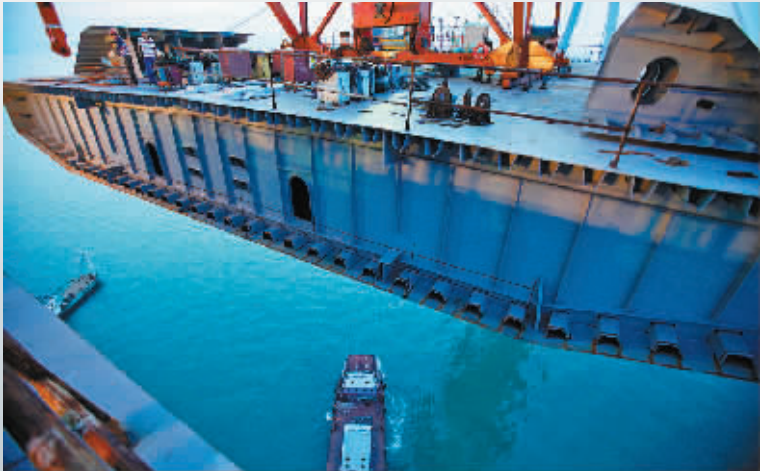
在象山港大桥合龙前一天，大桥只剩下最后一个“豁口”。
