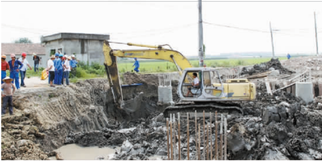
在事故点挖掘截断的电缆
