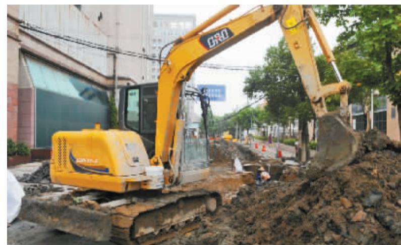
昨天，江北区文教路综合整治工程开工，工人正在用挖掘机开挖污水、雨水管道，预计总工期100天。该工程南起范江岸路，北至环城北路。
