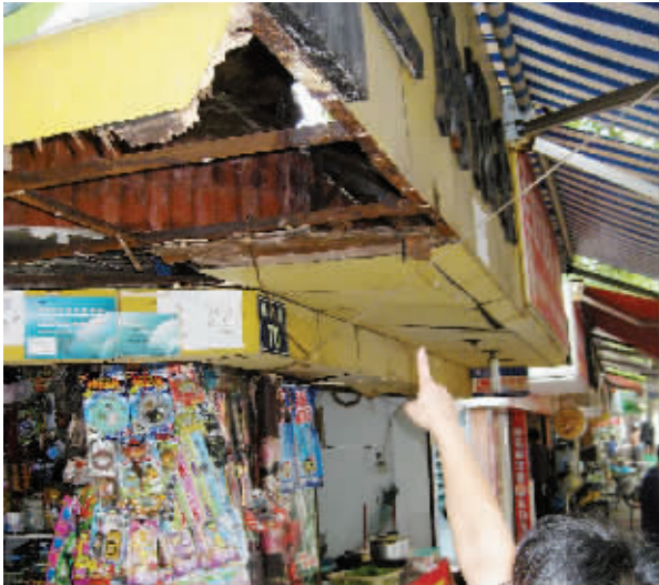
招牌已破烂不堪，铁框子已生锈，想要维修却碰到难题。
