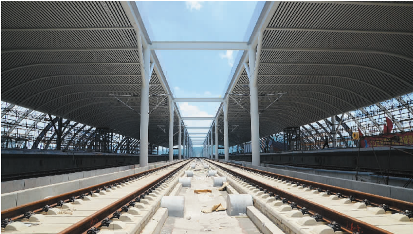
杭甬客专铁轨铺毕
