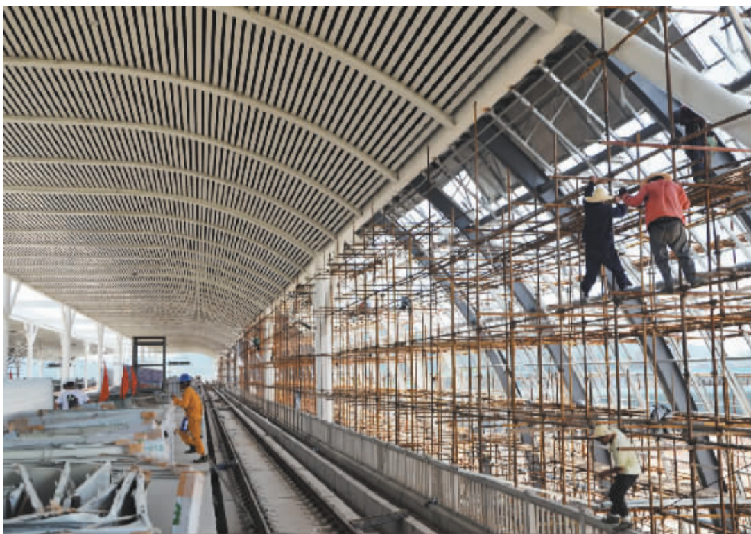
余慈站站台顶棚外幕墙正在施工。
