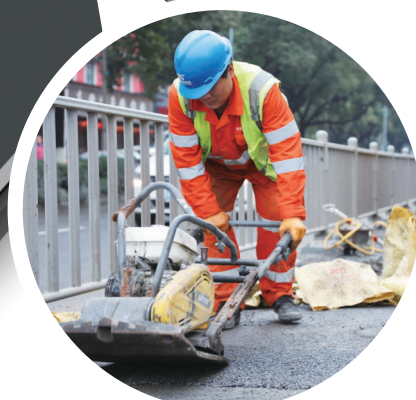
工作人员对修补后的路面进行压实
