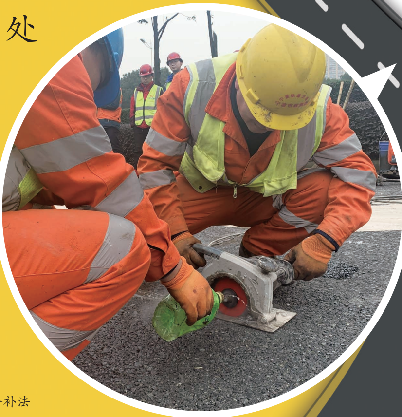
对坑洞路面进行切割,准备填充材料。 记者 陈嫣然 摄
