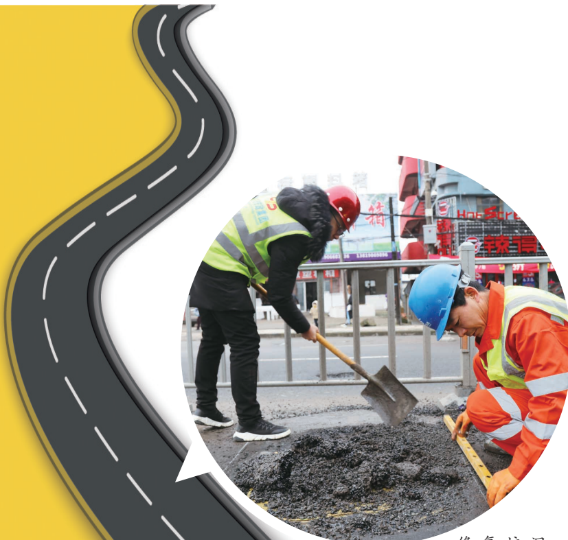
修复坑洞前,工作人员先要测量好面积
