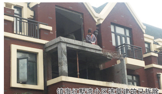
镇海红墅湾小区违章建筑已拆除
