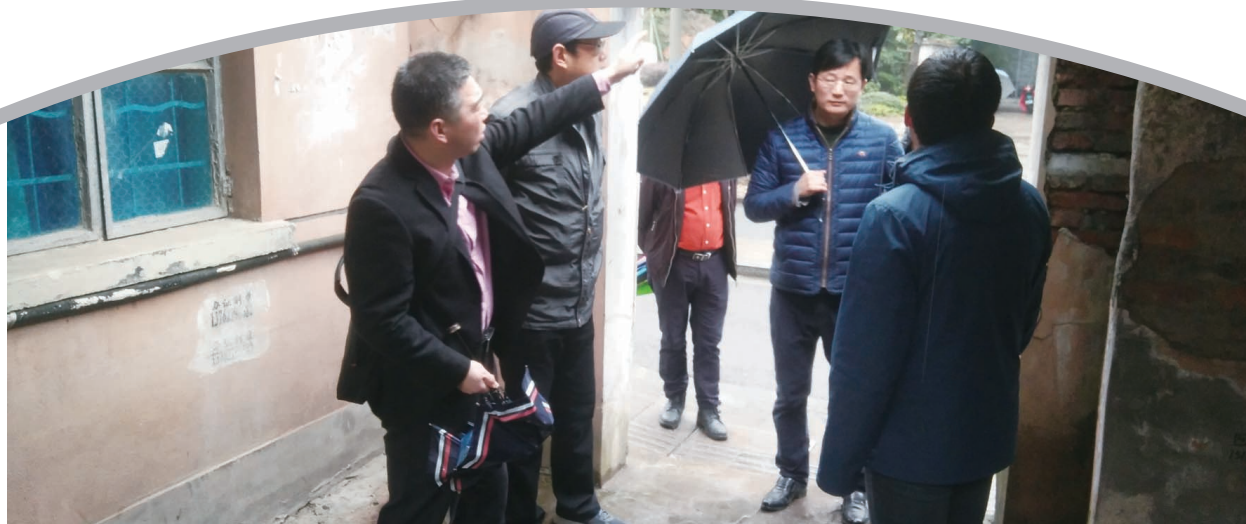
海曙区住建局会同相关单位到老楼现场勘查 海曙住建局 供图
