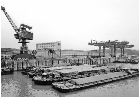
衢州港龙游港区桥头江作业区码头。
