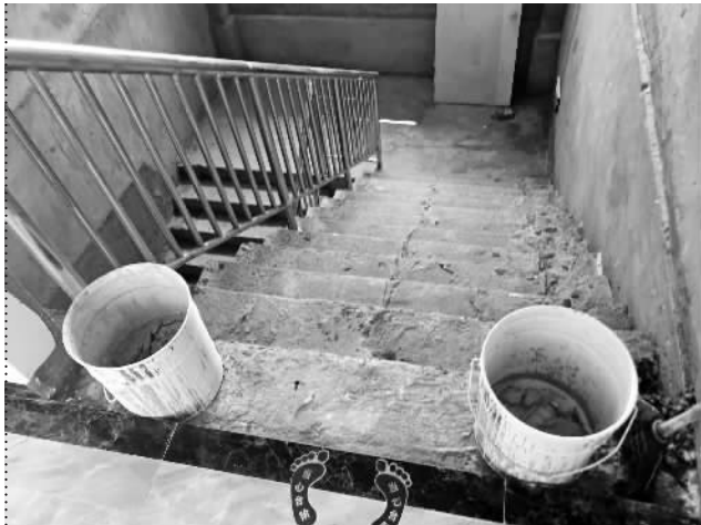
▲10楼通往11楼的楼梯处
