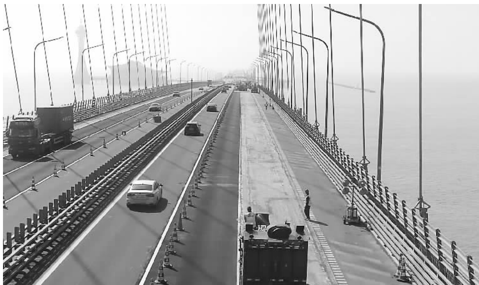
今年4月,路宝新材料在杭州湾跨海大桥南航道桥钢桥面铺装更换完成。
