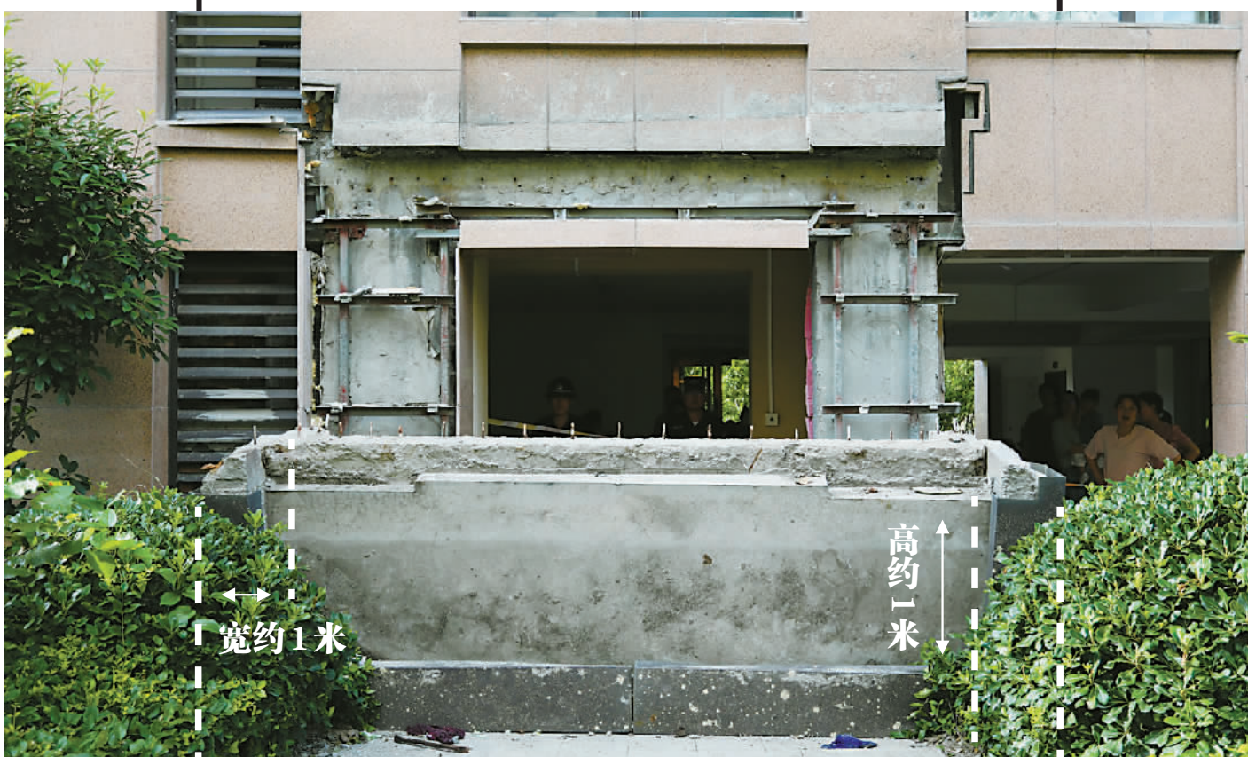
掉落在楼道口的混凝土雨棚。通讯员供图
