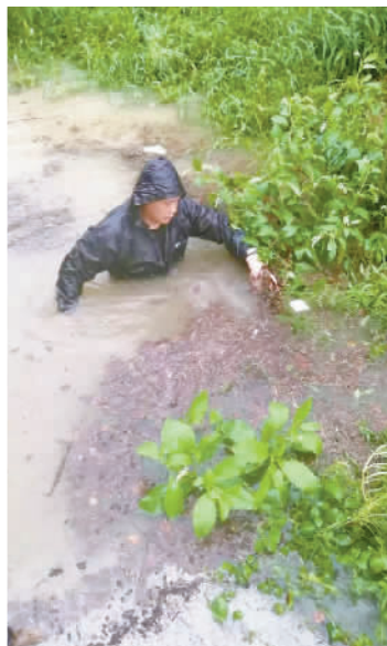
江北慈城镇公有村溢洪道排水不畅,村党支部书记陈国栋带领两名干部,跳进齐胸深的水中去清理,最终用了半个多小时清理干净。 通讯员供图
