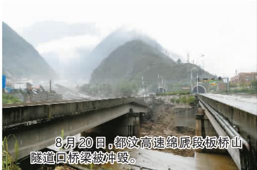
8月20日，都汶高速绵虎段板桥山隧道口桥梁被冲毁。
