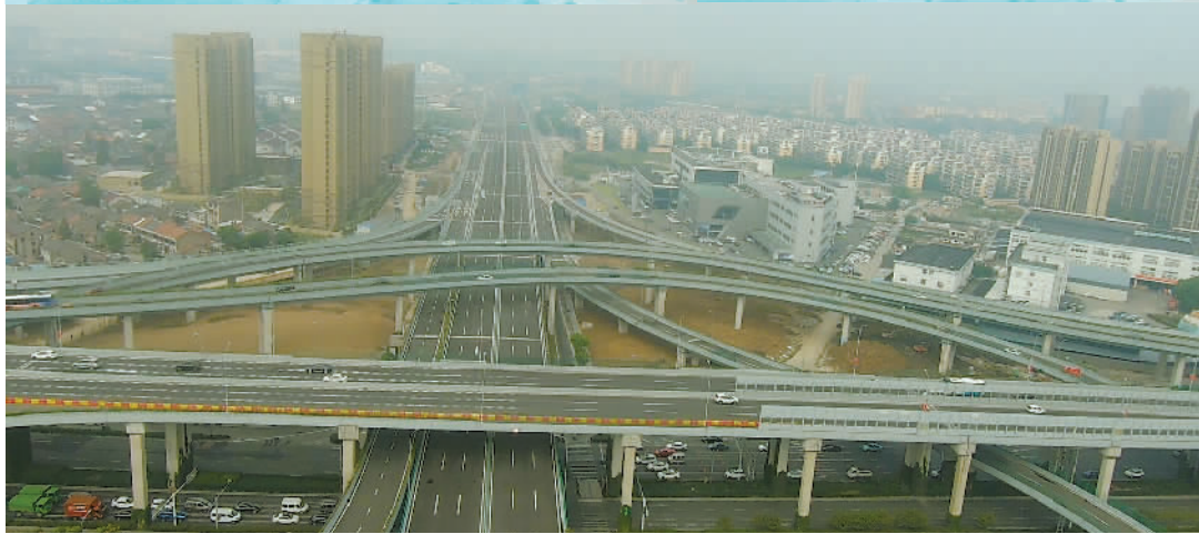
环城南路西延启动段(机场路-薛家路)现状。市住建局供图
