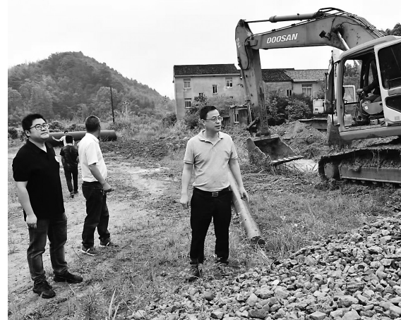
导师带徒推进第三水厂项目顺利开展 通讯员 供图
