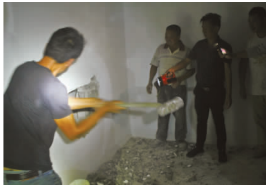
工友们正在凿墙救人。通讯员供图
