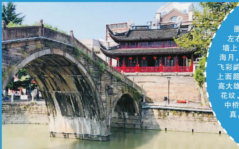
位于浙江余姚，又名舜江桥，始建于北宋庆历年间，原系木桥。到了元朝，有个叫惠兴的和尚发起筑石桥，没造到一半便去世了。有个道士李道宁主持继续造桥，到元至顺三年（公元1332年）终于建成，定名为通济桥。现存的通济桥是清雍正七年至九年（公元1729—1731年）重建，用木椿2100根，是一座陡拱式三孔两墩石桥，桥面中心宽5.61米，主孔净跨14.2米。
