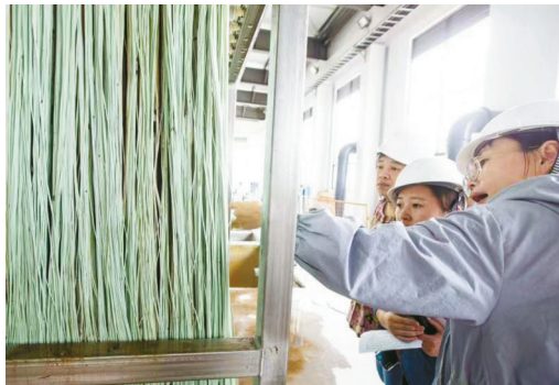
技术人员检查MBR膜安装情况。记者 刘波 摄
