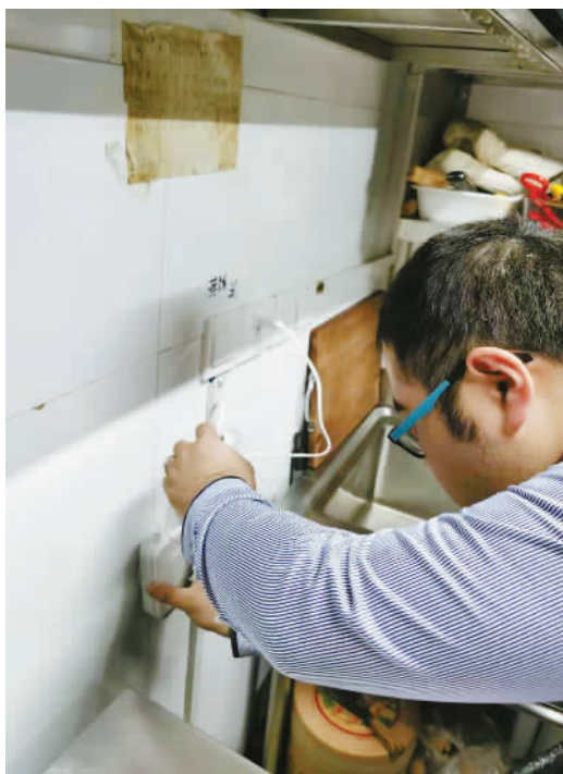
工作人员正在安装报警器。记者 毛雷君 摄
