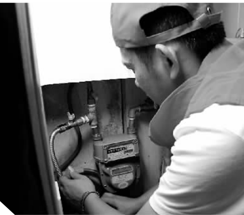
代办员上门为残疾人家庭免费更换燃气管。
