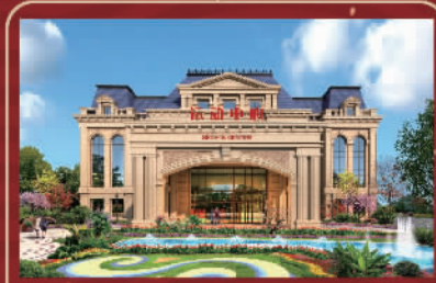
运动中心 (建设中)
