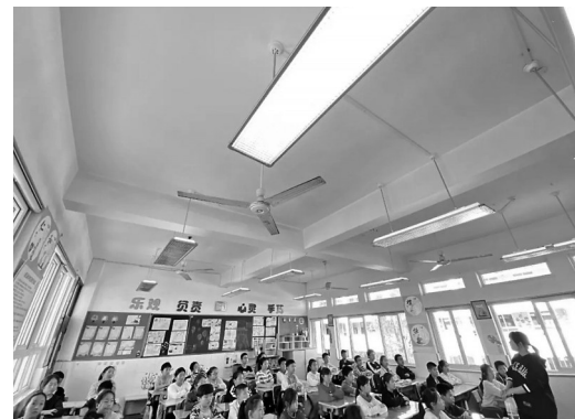
教室里安装了多盏护眼灯。学校供图
