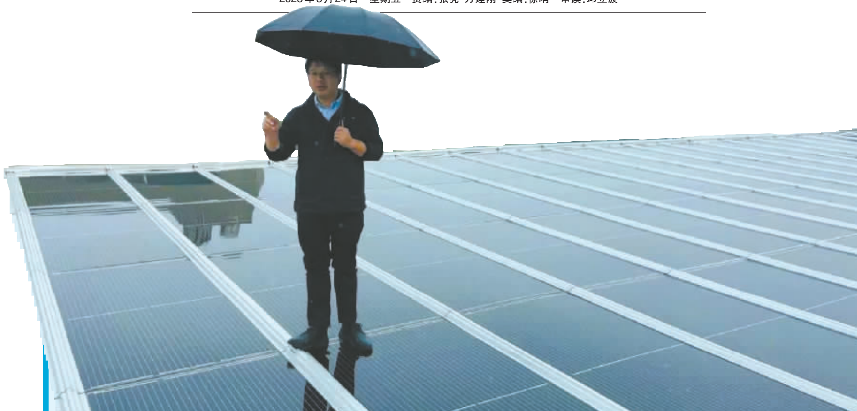
浙大宁波理工学院光伏屋顶可承重160斤的成人。通讯员供图
