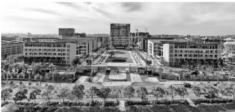
鄞州职业教育中心学校迁建项目。
