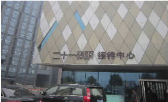
21 码头接待中心设在项目现场
