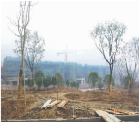
施工中的项目现场
