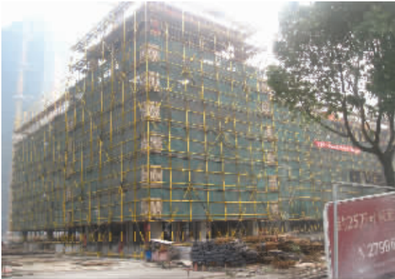
项目现场施工图
