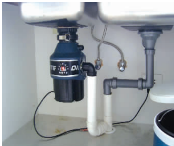
厨房垃圾粉碎机安装示意图
