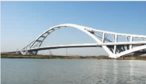
明州大桥的通车带动镇海房地产发展
