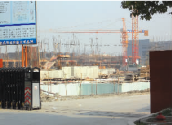
荣安蝶园项目现场
