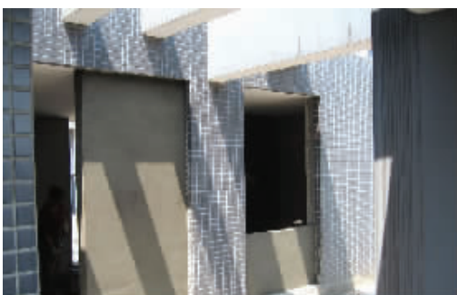
19 楼屋南侧小天井花园
