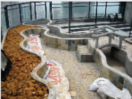
花园填土完成
