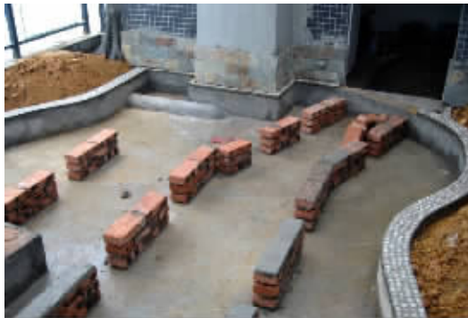
用来铺设防腐木平台
