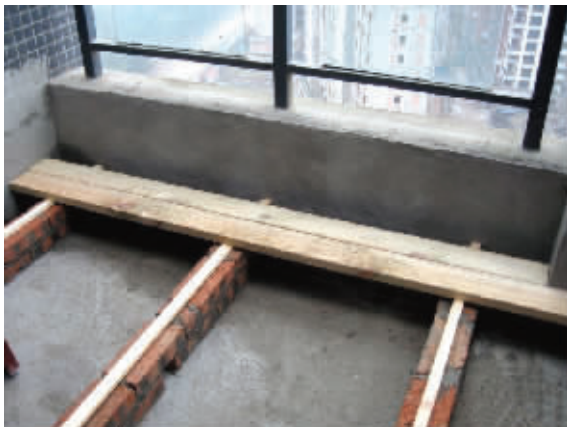
开始铺设防腐木
