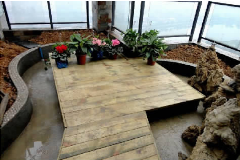
环形水池完工
