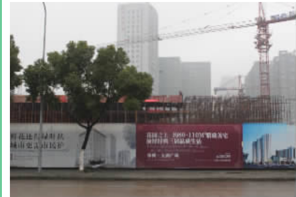
工程进度到地上一层
